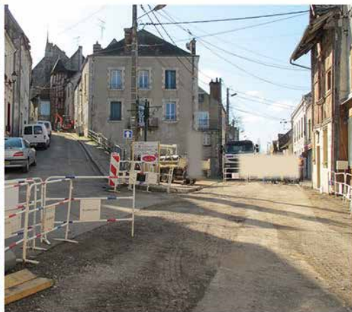
Rue haute, rue des prés durant la dernière phase de travaux en 2024
